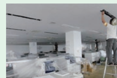
LED照明への切り替え
