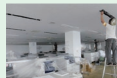
LED照明への切り替え
