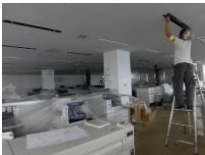
LED照明への切り替え
