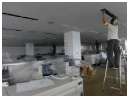
LED照明への切り替え
